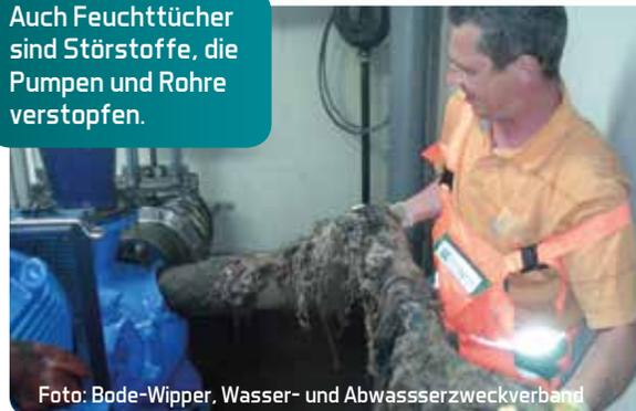
Foto: Bode-Wipper, Wasser- und Abwasserzweckverband
